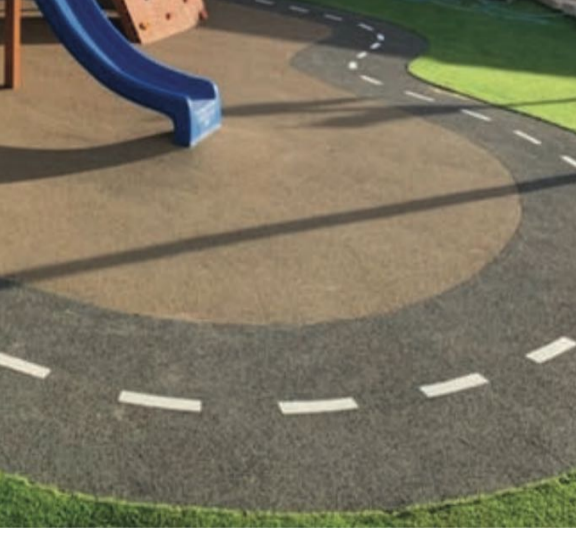
Loop path - Wet pour rubber
